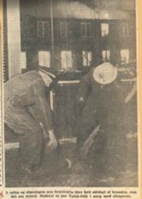
En del af fabriken blev brændt ned af flammerne, som der ses ovenfor. Nederst er der fotografier af en af de ødelagte bygninger.
